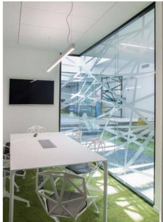
La cloison Pureline Vitrée Toute Hauteur se distingue par sa conception innovante, composée de deux parements indépendants permettant l'intégration de vitrages simples ou doubles feuilletés d'une épaisseur de 10 à 12 mm.
