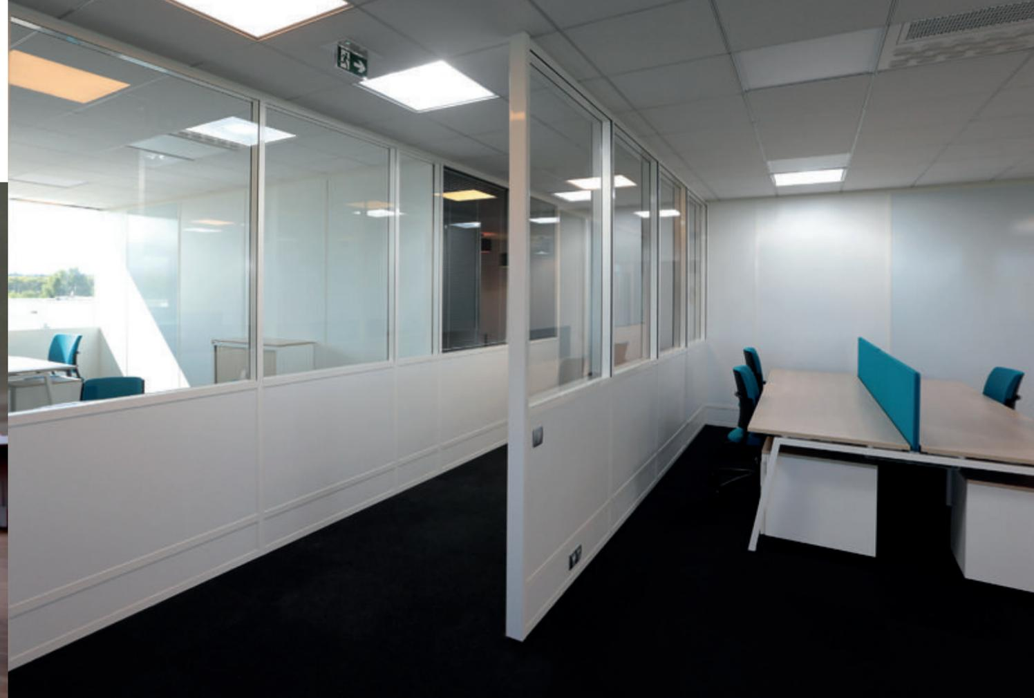
Dotée d'une structure en aluminium de 80 mm d'épaisseur, cette cloison offre une base solide et durable.
